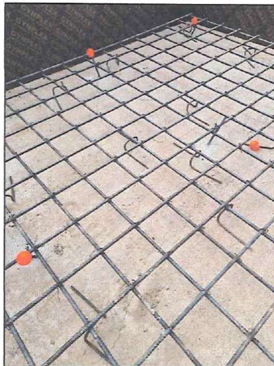
Imagen N° 24: Habilitación y armado de malla para zapata
