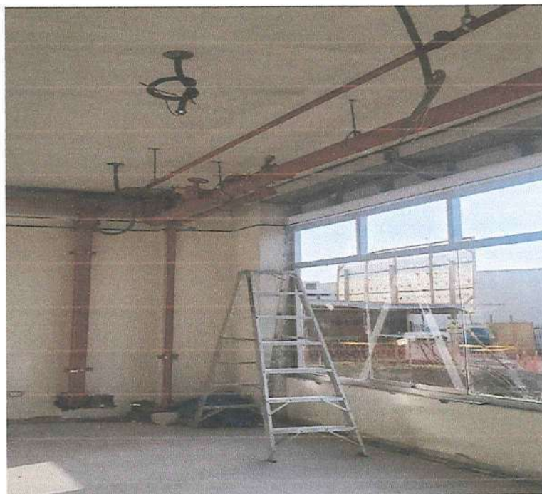
IMAGEN N°31: INSTALACIÓN DE SISTEMA CONTRA INCENDIO
