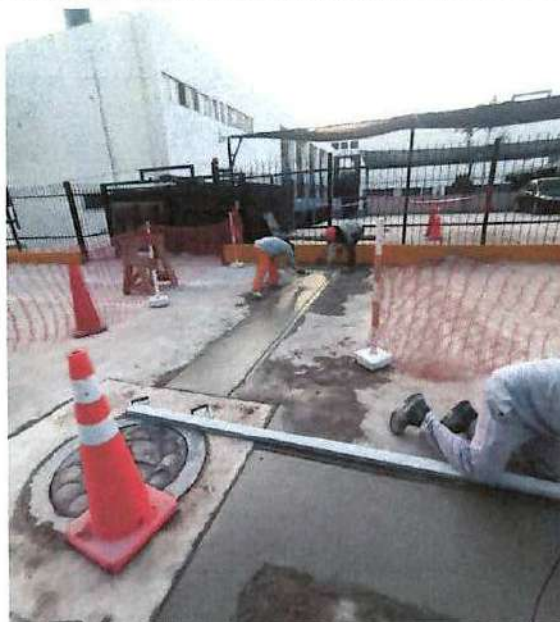
IMAGEN N°04: SEÑALIZACIÓN DEL ÁREA DE TRABAJO EN OBRA
