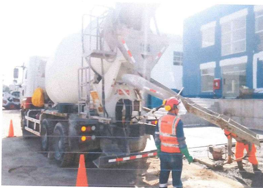
IMAGEN N°04: SEÑALIZACIÓN DEL ÁREA DE TRABAJO EN OBRA
