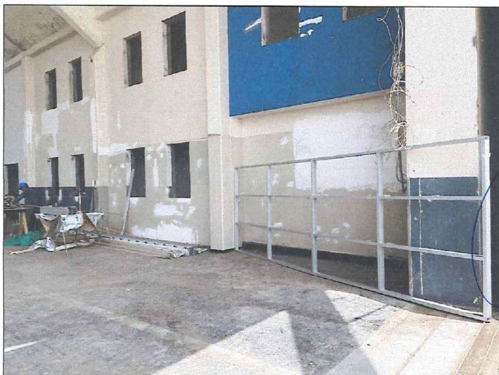
Imagen N° 36: Habilitación y armado de marco para ventanas del hangar 6 y 7
