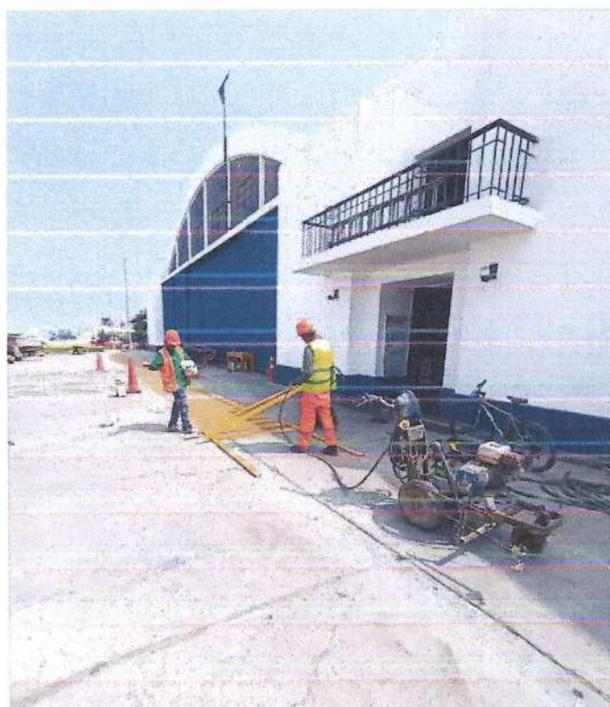
IMAGEN N°09: COLOCACION DE MICROESFERAS
