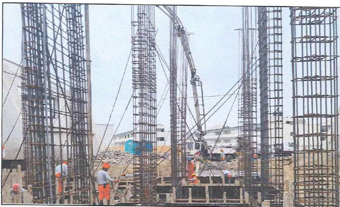
Imagen N° 27: Encofrado para zapatas
