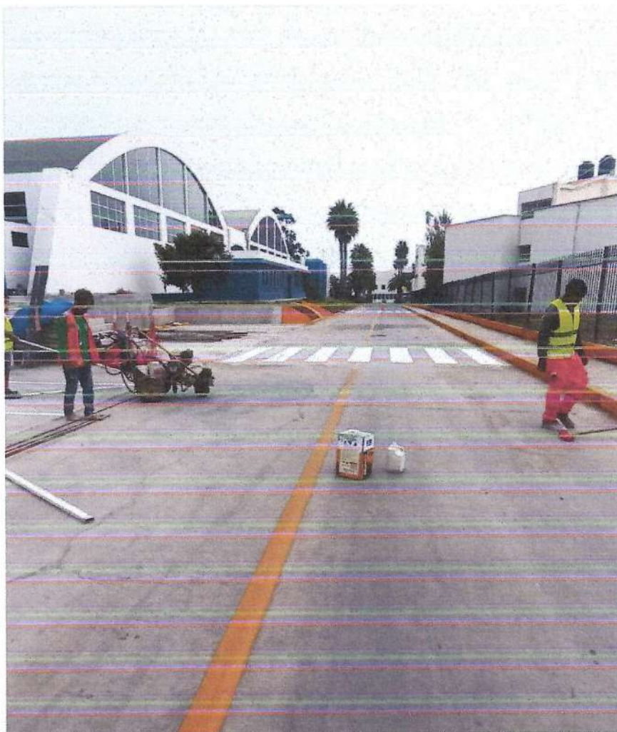
IMAGEN N°09: LIMPIEZA GENERAL DE PAVIMENTO
