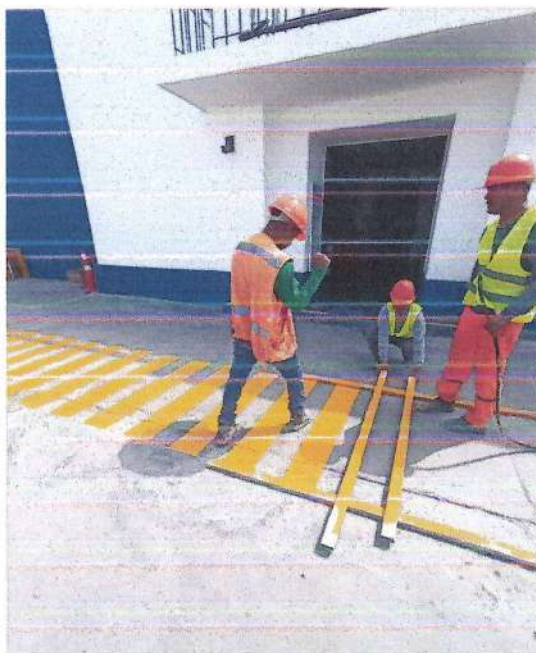
IMAGEN N°09: COLOCACION DE MICROESFERAS
