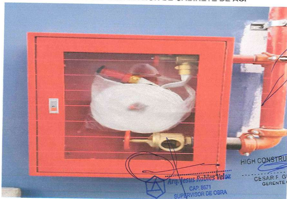
IMAGEN N°24: INSTALACIÓN DE GABINETE DE ACI
