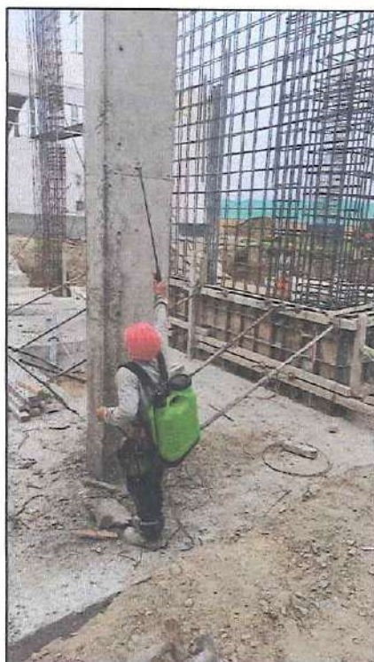
Imagen N° 35: Curado con aditivo de columnas y placas
