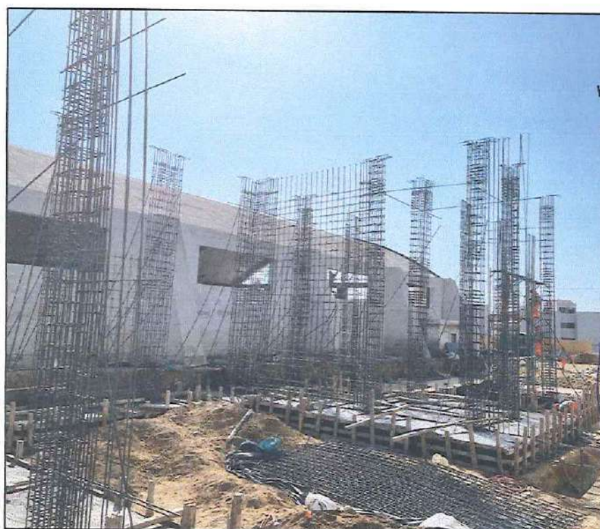
Imagen N° 28: Vaciado de concreto para zapatas
