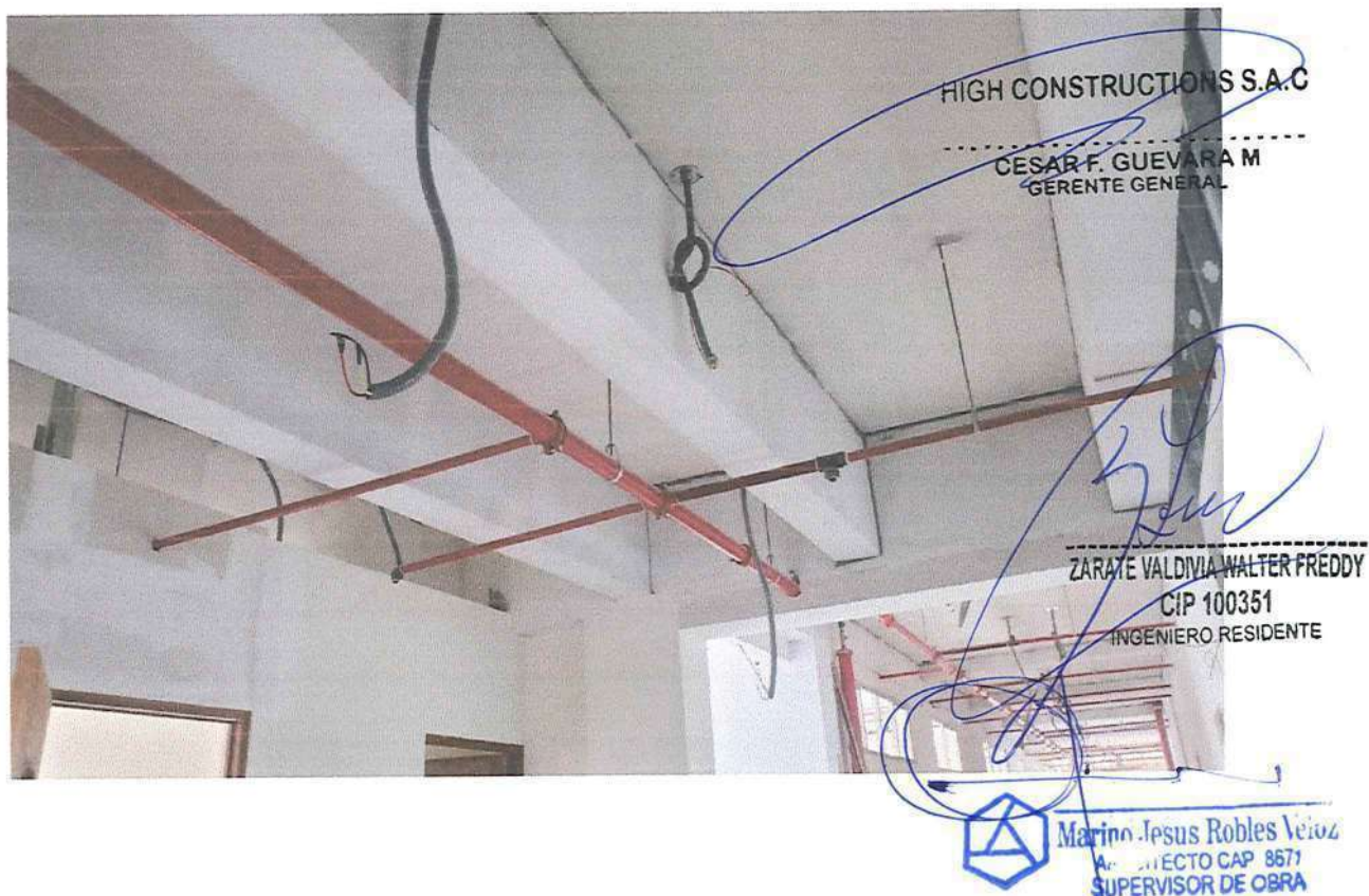
IMAGEN N°31: INSTALACIÓN DE SISTEMA CONTRA INCENDIO
