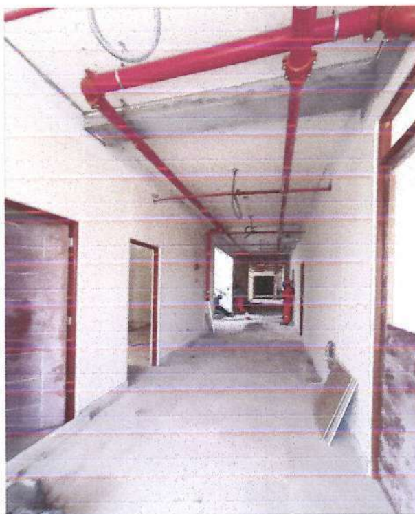
IMAGEN N°12: PISO ACABADO DE CEMENTO PULIDO ANDINO GRIS CON LAMINA DE 3MM. Y ESPESOR DE 5 CM.
