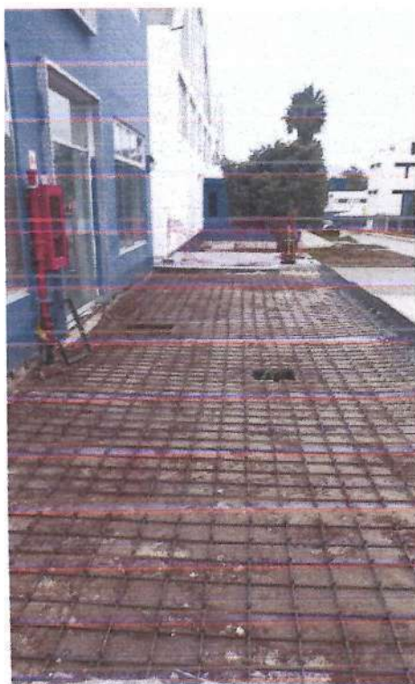
IMAGEN N°12: PISO ACABADO DE CEMENTO PULIDO ANDINO GRIS CON LAMINA DE 3MM. Y ESPESOR DE 5 CM.
